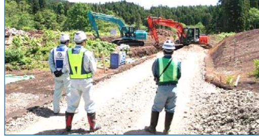
函館江差自動車道木古内町 幸連橋下部外一連工事
