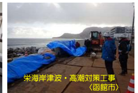
栄海岸津波・高潮対策工事 (函館市)
