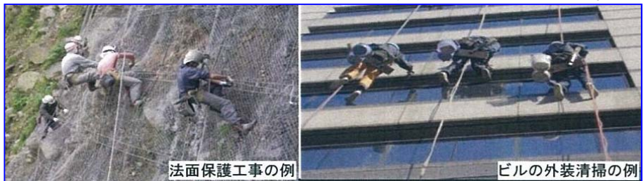
法面保護工事の例
