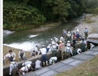
清掃する魚道は、今金町種川の下 ハカイマップ川のらせん式魚道と直 線式魚道の2ヵ所です。当日は88名 が参加。上流のらせん式魚道は、溜 まった土砂をスコップでかき出し、 バケツリレーで運搬。魚道の詰まり を解消しました。下流では魚道に乗 り上げた流木を除去しました。
